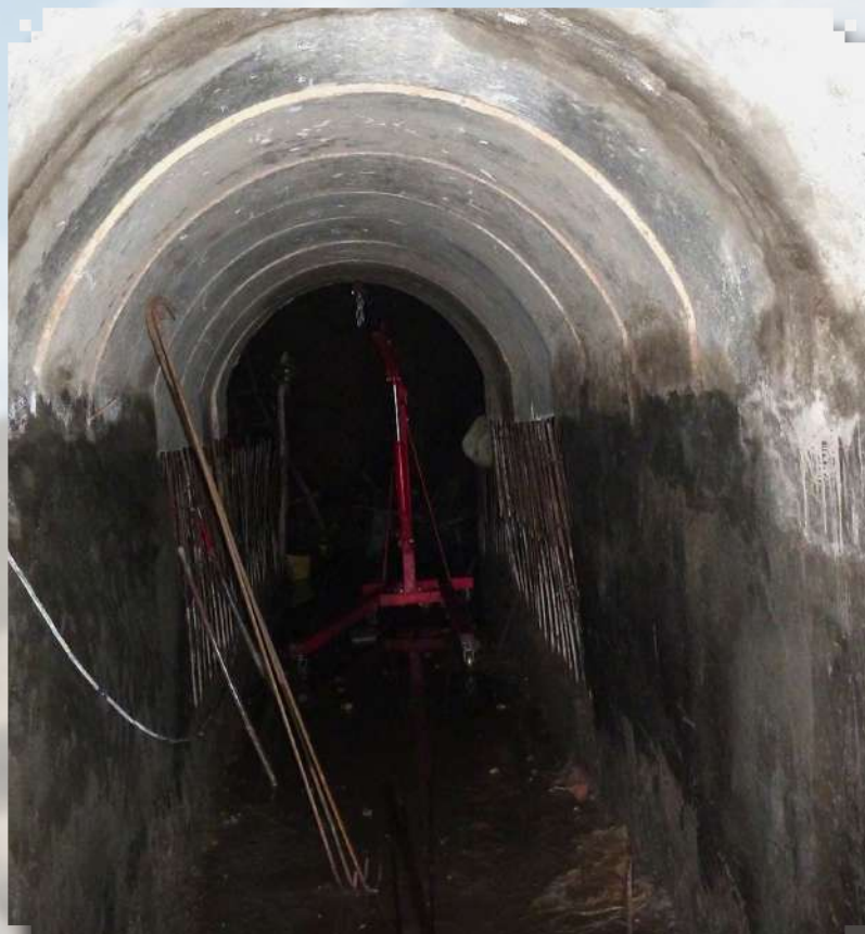
Photo 10 : Mis en place des installations hydro-électriques (passage dans un tunnel encours de travaux)
